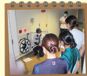
施設管理課職員による消火栓の説明
